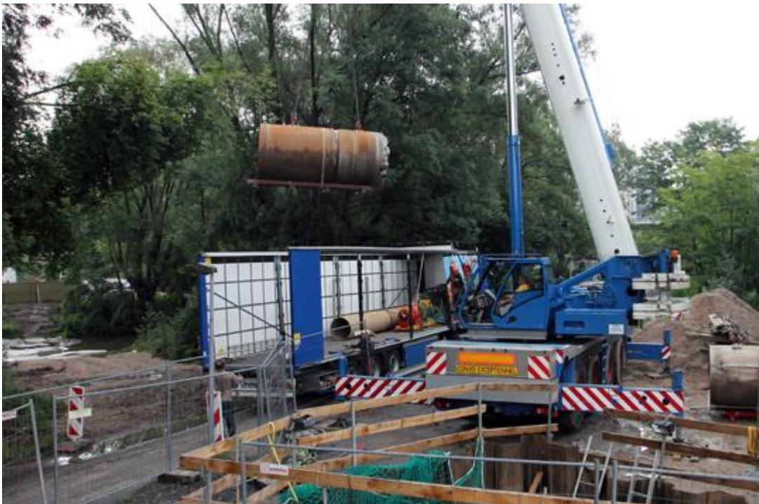
Nach dem Durchbruch der 110-Meter-langen Haltung wird die AVN1200 vom Zielschacht zum nächsten Einsatzort abtransportiert. Links im Hintergrund ist der erfolgreich unterquerte Fluss „Alb“ zu sehen.
