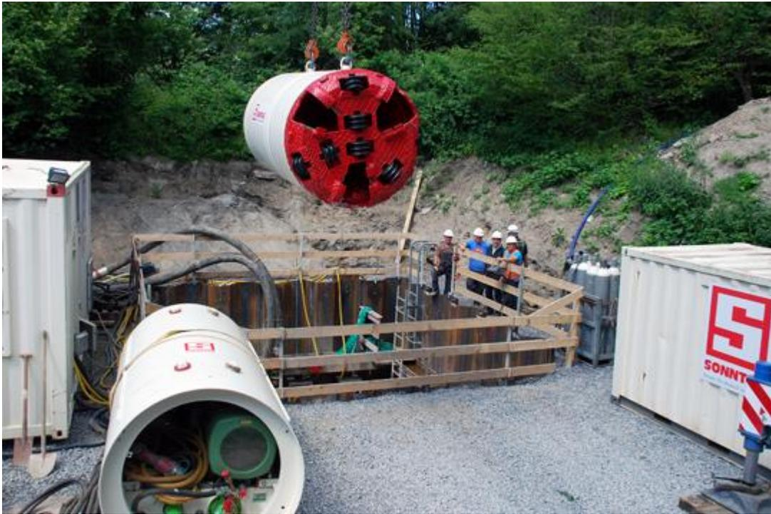
Die AVN-Maschine mit einem Bohrdurchmesser von 1.505 Millimetern fuhr insgesamt 6 Haltungen in Karlsruhe auf.
