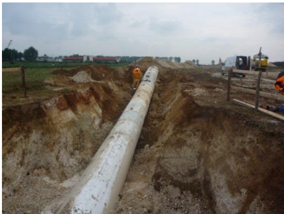
Nach über 1.000 Metern Vortrieb trat die Pipeline auf der gegenüberliegenden Flussseite präzise am Austrittspunkt aus.
