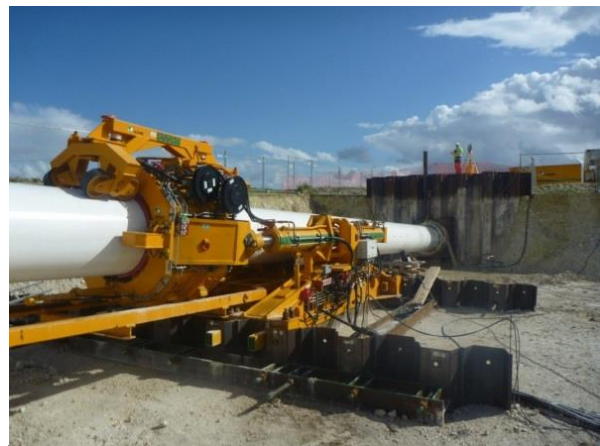
Der Pipe Thruster stellt bis zu 500 Tonnen Schubkraft auf der Startseite zur Verfügung.
